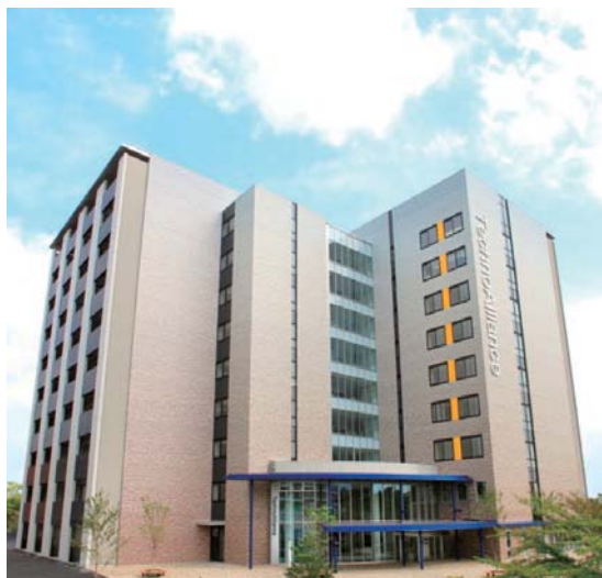
大阪大学 テクノアライアンス棟
